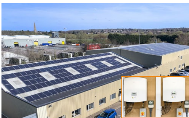
Grundfos Rooftop, UK 123.4kW
