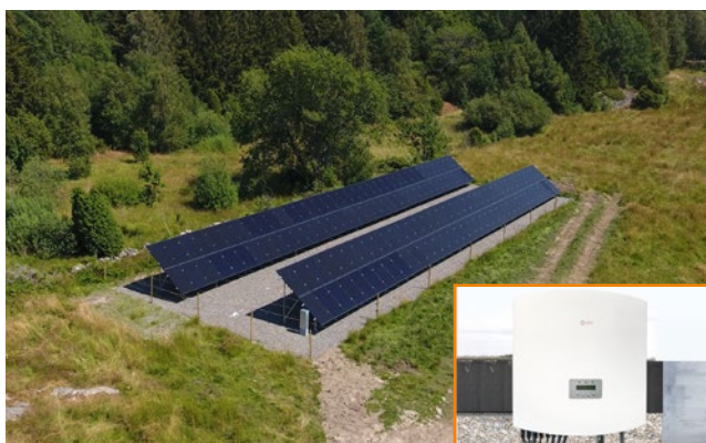
Västra Götaland, Sweden 43.31kW
