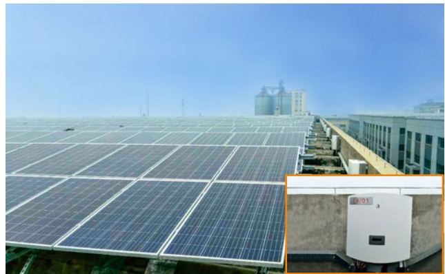
Changzhou Vaillant 2MW
